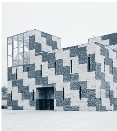
Modern verbaut: Gefahrenstofflager der Humboldt-Universität Berlin (Architekt: Benedict Tonon)
